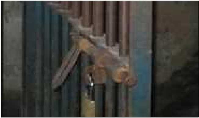
FERROLHO COM PORTA CADEADO Deverá ser fornecido cadeado para tetra-chave, referência modelo Q-60, da Pado.
