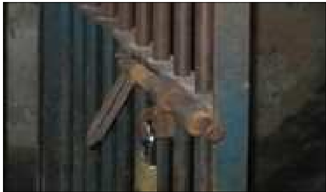
FERROLHO COM PORTA CADEADO Deverá ser fornecido cadeado para tetra-chave, referência modelo Q-60, da Pado.
